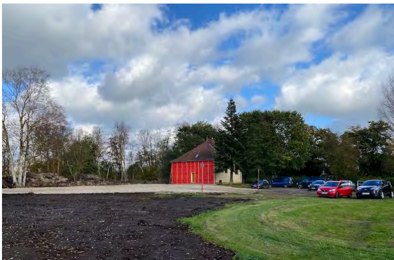
Der lange Anbau links ist abgerissen und bereit für das Fundament des Neubaus.
